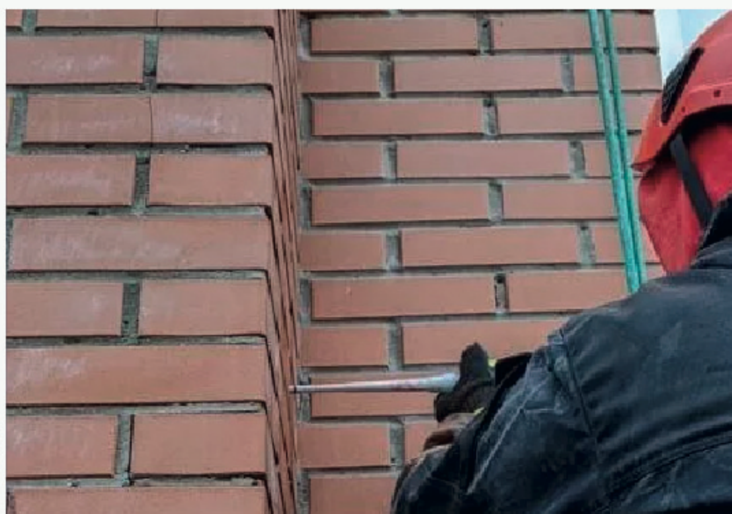
г. Колпино, Загородная 42 Ремонт фасада спиральными анкерами RSA-tie
