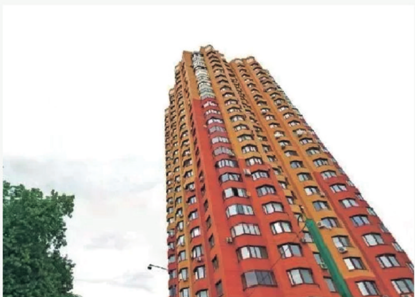
г. Москва, высотный жилой дом на ул. Лодочная
