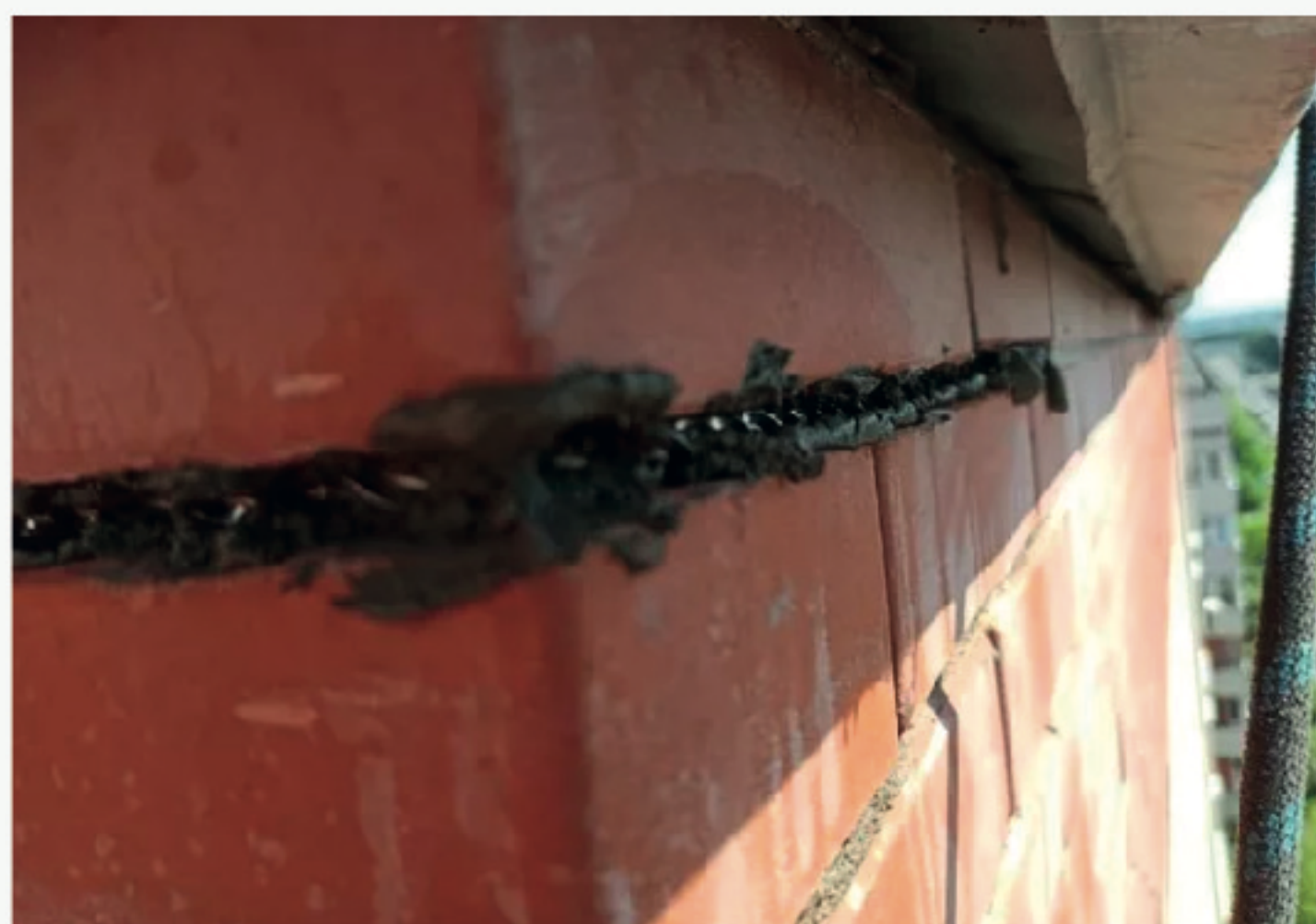
г. Санкт-Петербург, Ветеранов д. 108, Ремонт облицовки МКД
